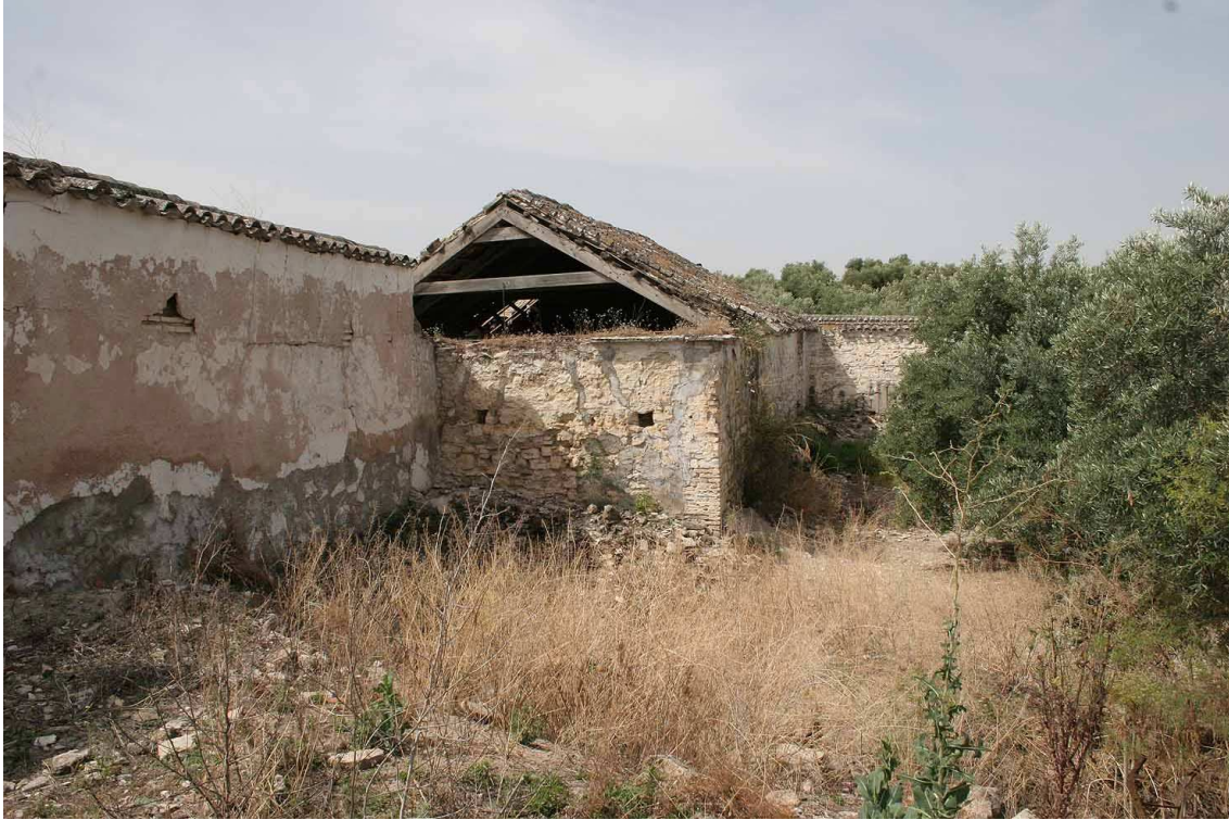
Estado actual de algunas de las construcciones de Los Molinos
